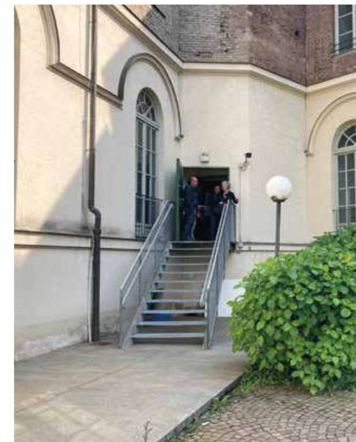
SCALA INTERNO CORTILE - FOTO 11
