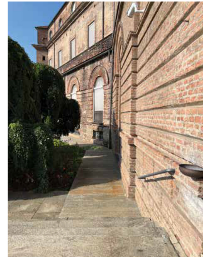
PARTICOLARE SCALA INGRESSO - FOTO 6
