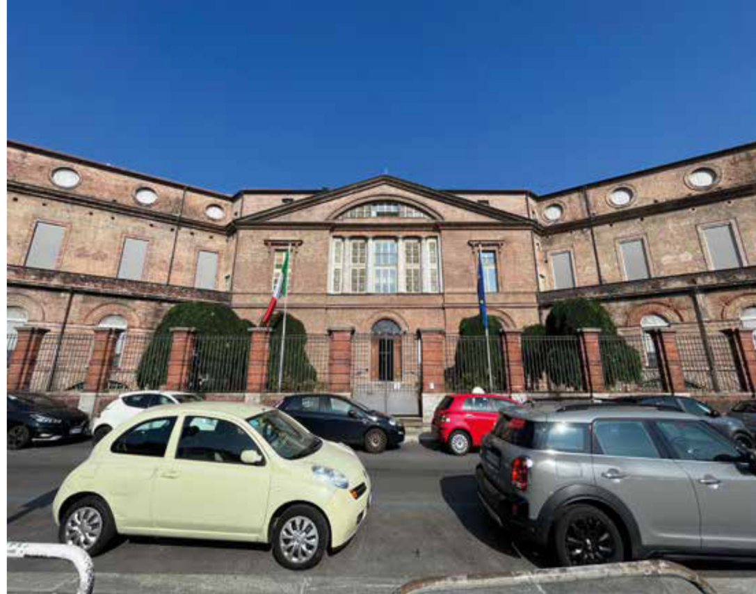
INGRESSO PRINCIPALE DALL'ESTERNO - FOTO 1
