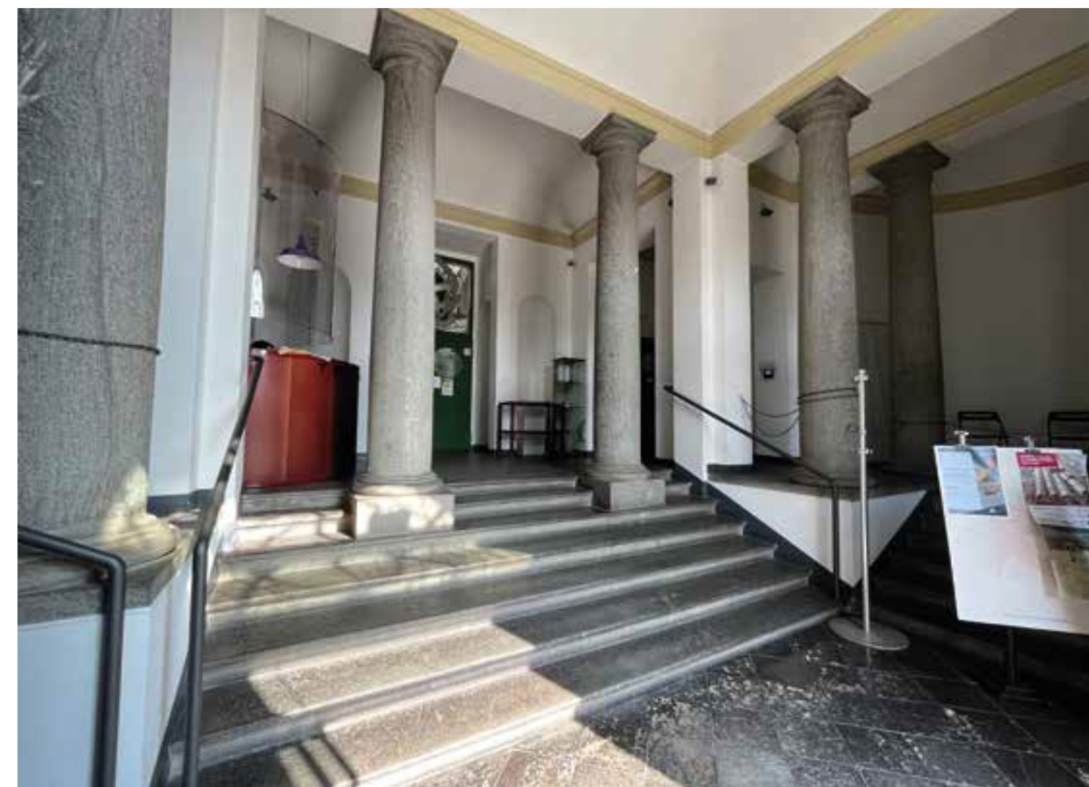
SCALA INTERNA - FOTO 9
