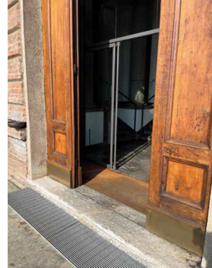
PORTONE D'INGRESSO - FOTO 8
